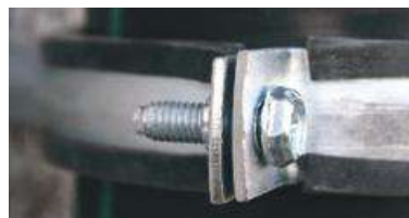
Stopnja pritrjenosti spodnje objemke
