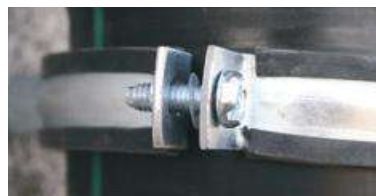
Stopnja pritrjenosti spodnje objemke
